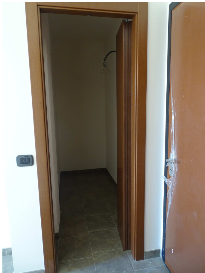
Locale di servizio
