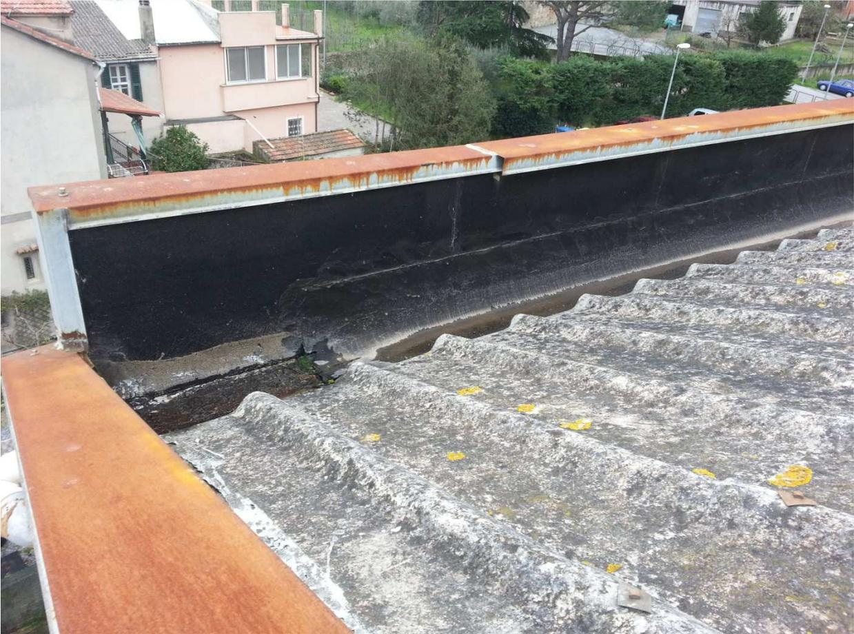
Copertura in lastre di cemento-amianto
