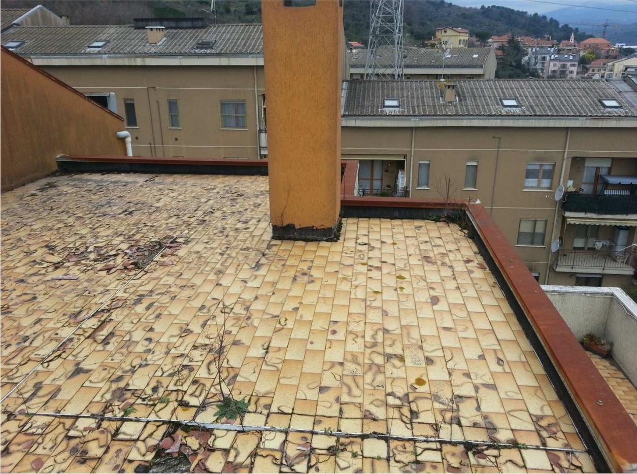
Cornicione con funzione di canale di gronda
