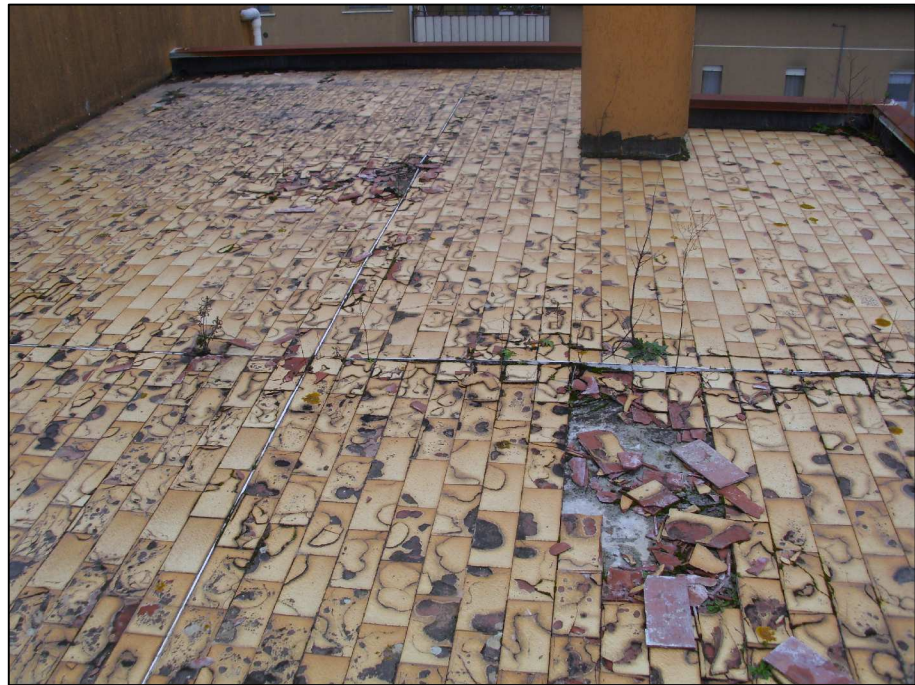
Particolare terrazze piane da ripristinare
