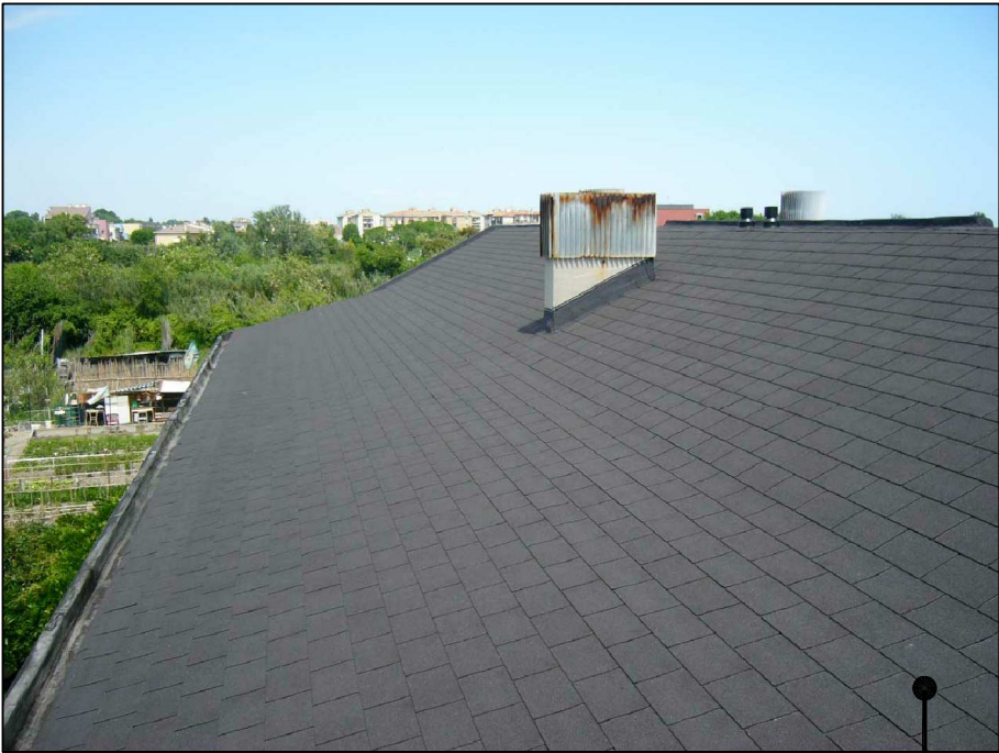
Esempi della tipologia del materiale e di posa del nuovo manto previsto
